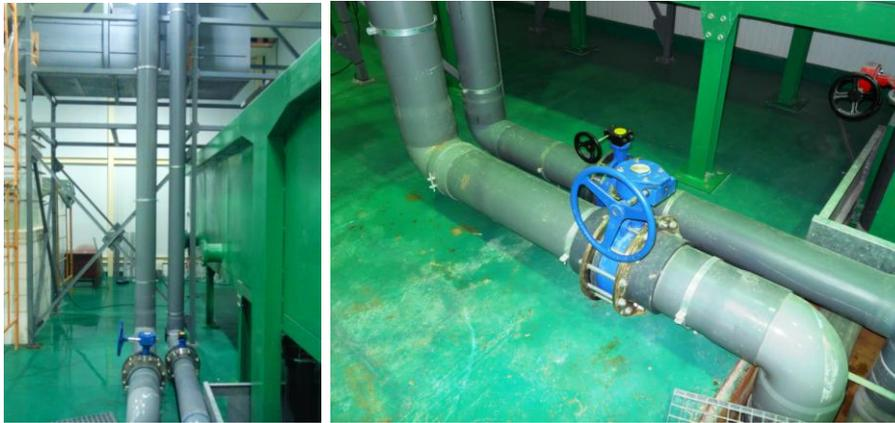
**Figura 23: Izquierda, conducciones en presión; Derecha, detalle de la válvula de mariposa.**
